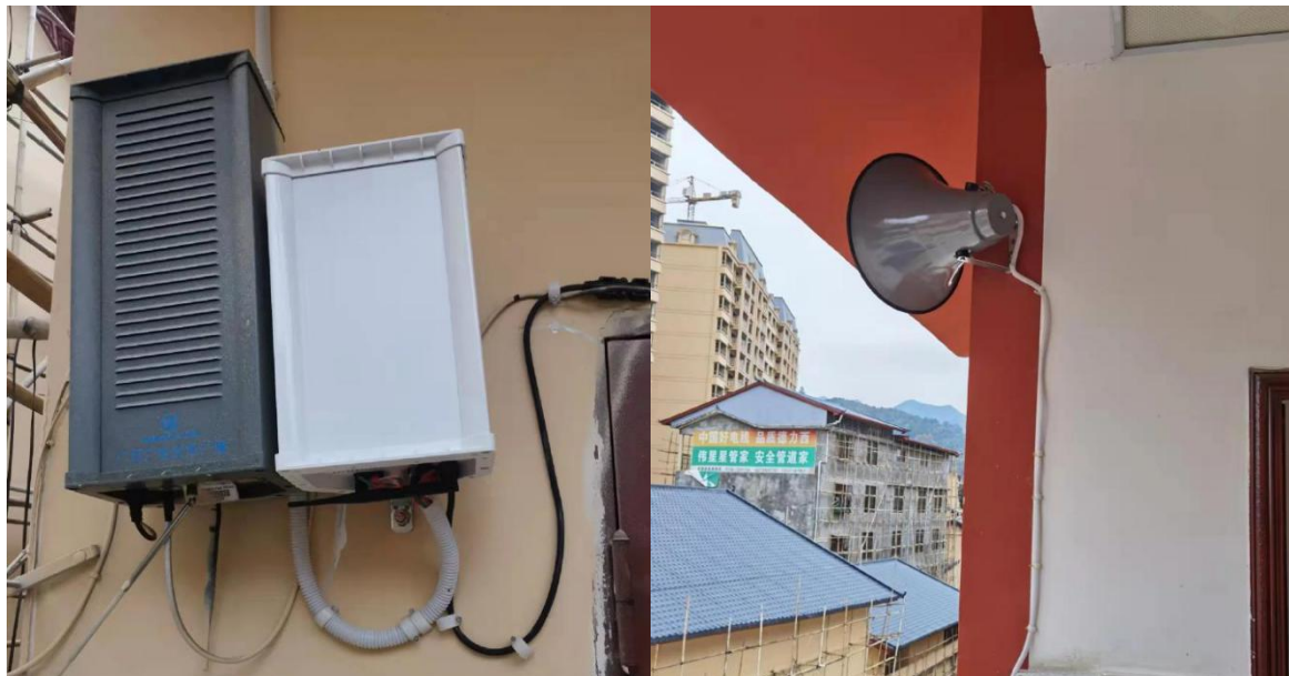
(智慧广播安装现场图片)
